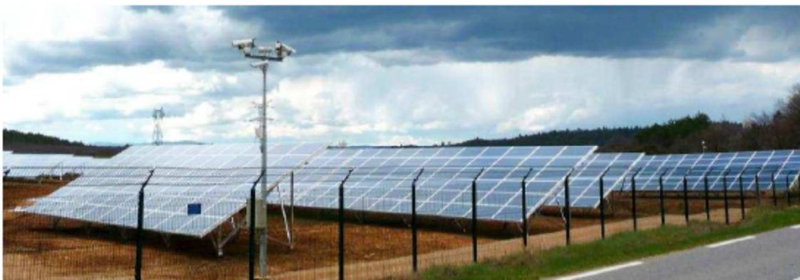
Figure 34 : Exemple de clôture et système de surveillance par caméras
