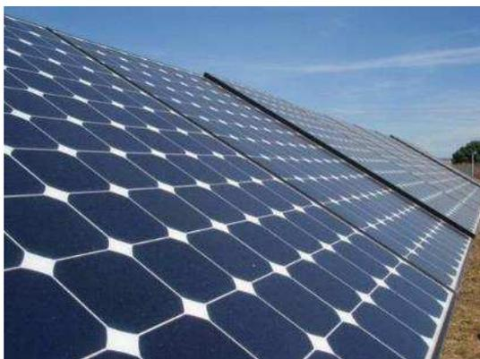
**Figure 24 : exemple de panneaux monocristallin SUNPOWER**
