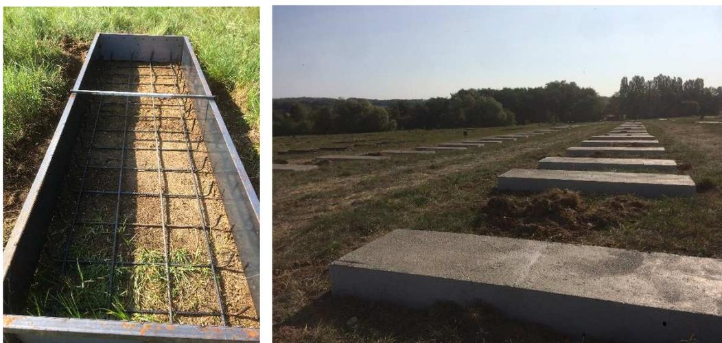
**Figure 26 : Photographie de mise en place de longrine – source : ENGIE**
