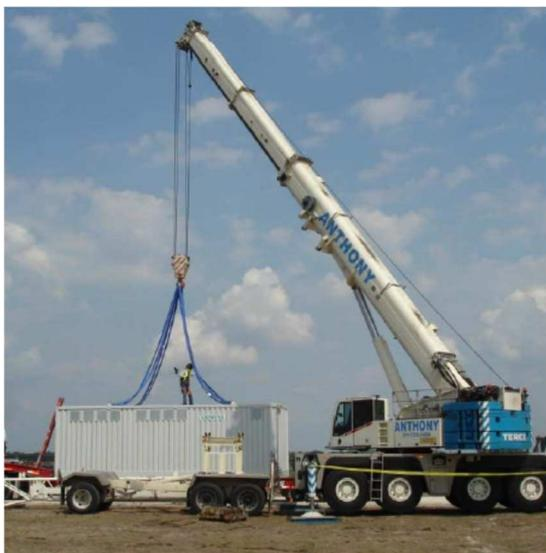
Figure 39 : Engin utilisé pour la pose des onduleurs
