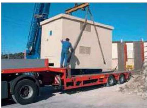
Figure 41 : Déchargement d'un poste électrique
