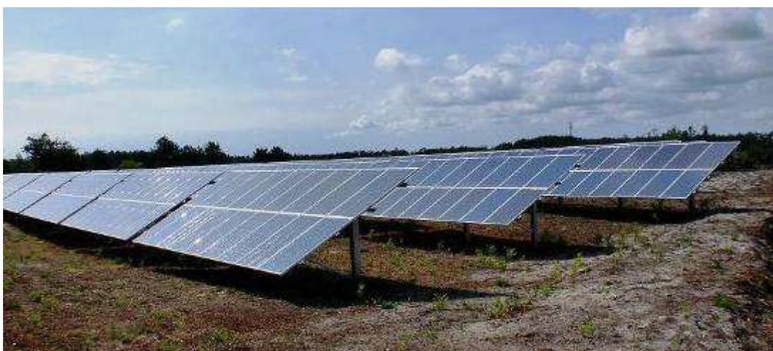
Figure 23 : Exemple de centrale photovoltaïque équipée de panneaux fixes – technologie cristalline (couche épaisse)
