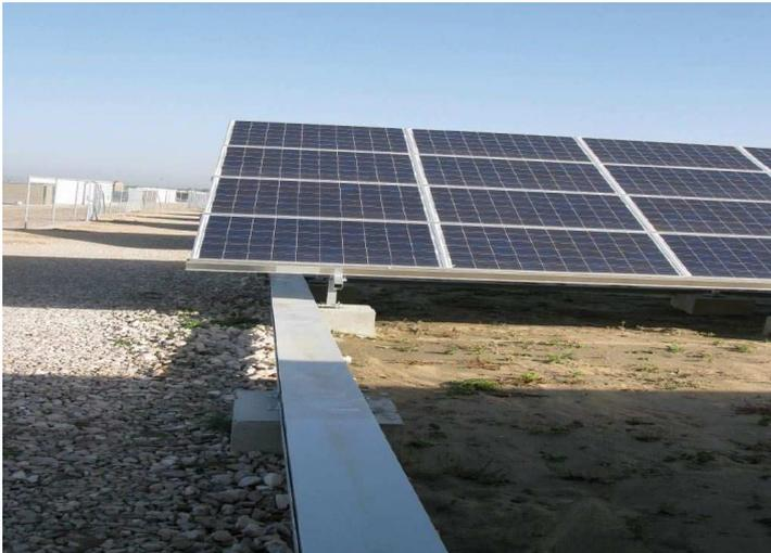
Figure 32 : Exemple d'un chemin de câbles
